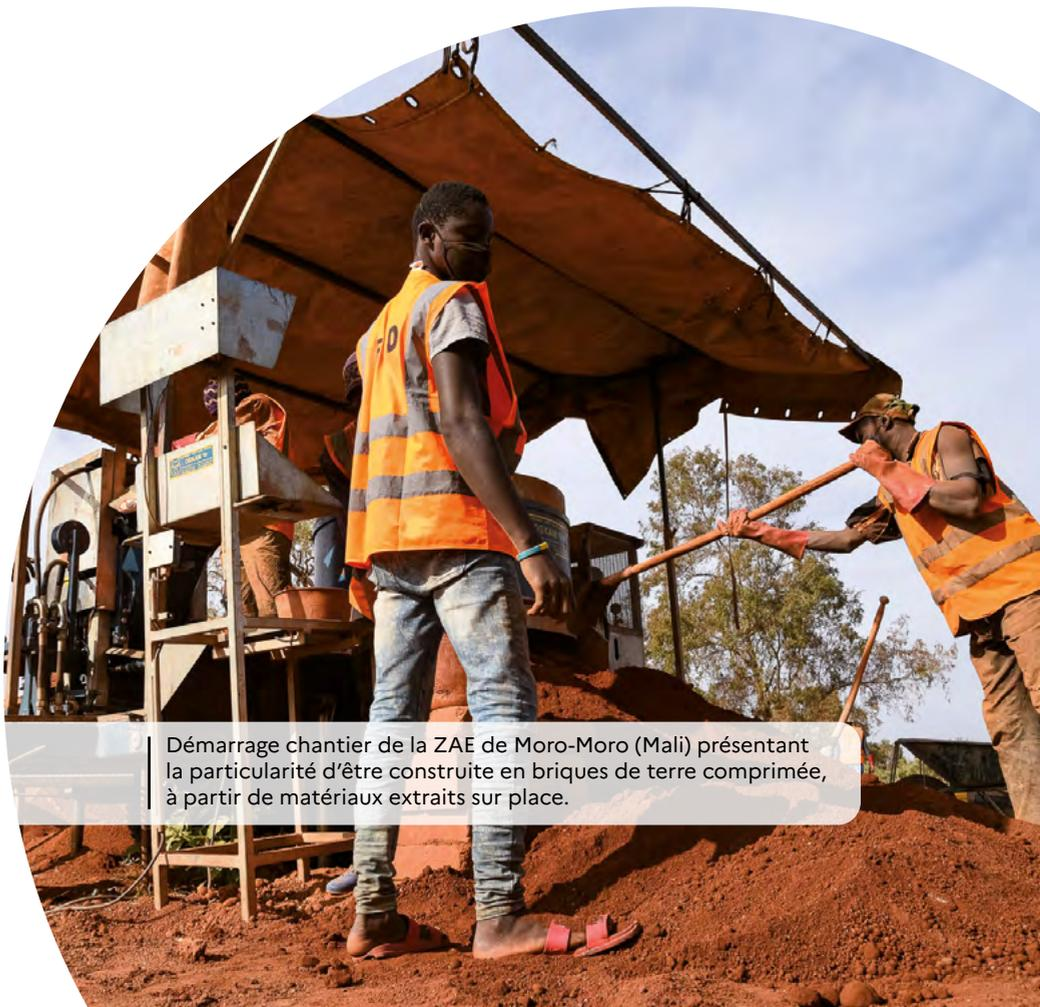
Démarrage chantier de la ZAE de Moro-Moro (Mali) présentant la particularité d'être construite en briques de terre comprimée, à partir de matériaux extraits sur place.
